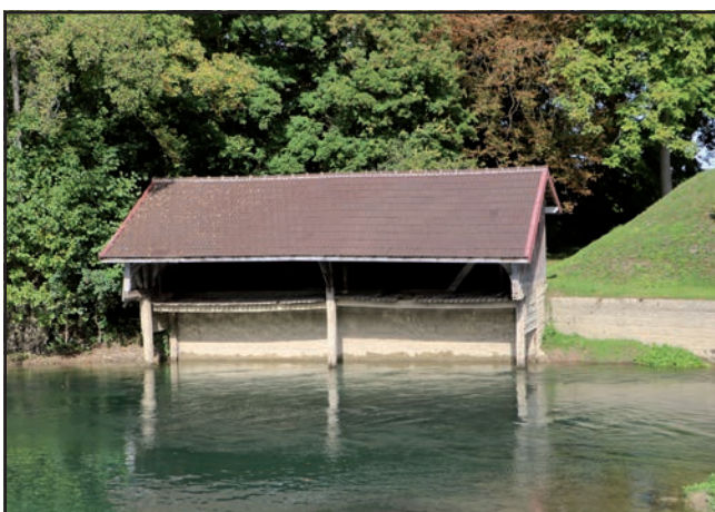
Le lavoir et son plancher mobile en position haute
